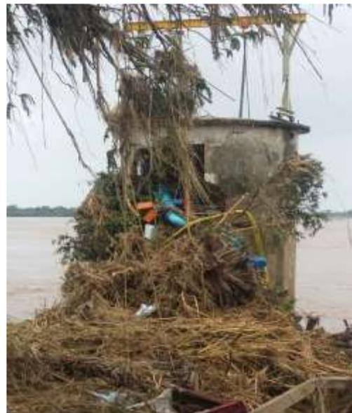
FIGURA 28 ESTAÇÃO DE CAPTAÇÃO DE ÁGUAS DESTRUÍDA APÓS CHEIAS DE 2015
