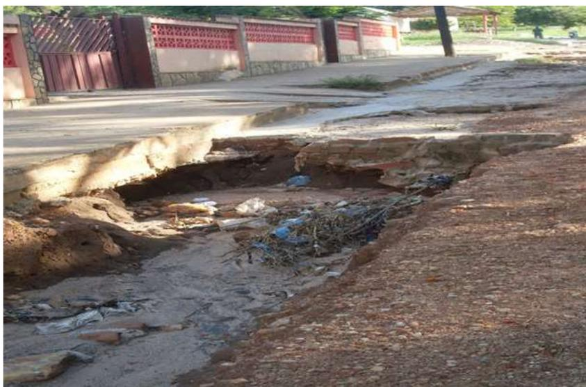
**FIGURA 50 DESTRUIÇÃO DA ESTRUTURA FRÁGIL DAS VALAS DE DRENAGEM**
